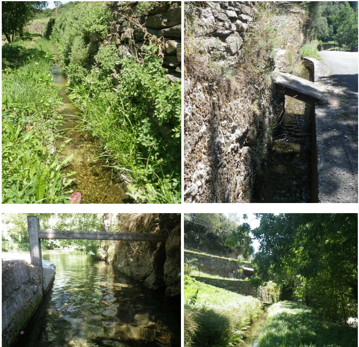
Figure 2 : Photos du canal de Campeménard
