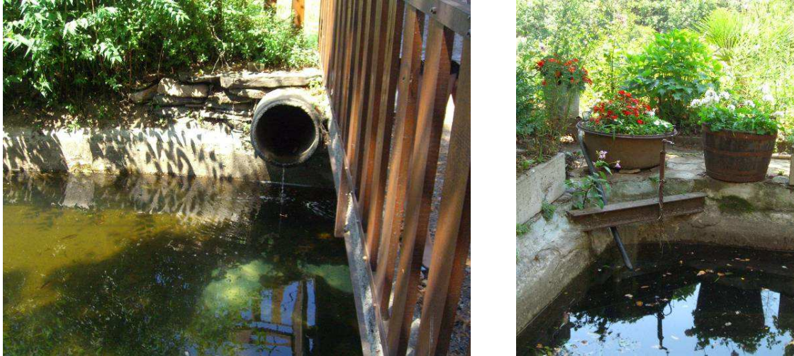
Figure 5 : Alimentation du bassin par le béal et vanne de décharge du bassin
