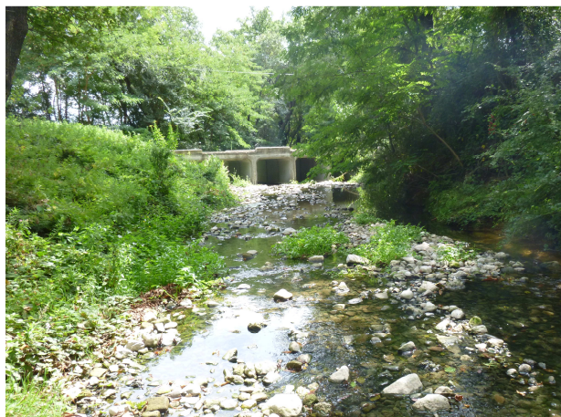
Vue vers l'amont – août 2014
