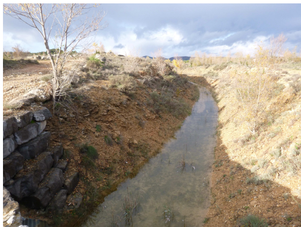
Canal de surverse – novembre 2014
