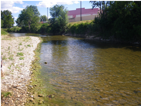
▲ Vue vers l'amont depuis l'aval du point
