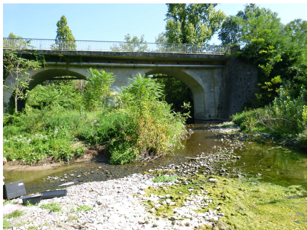
Vue vers l'amont – août 2014
