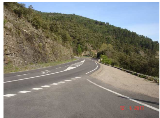
Site de stationnement aval sur la route nationale 106
