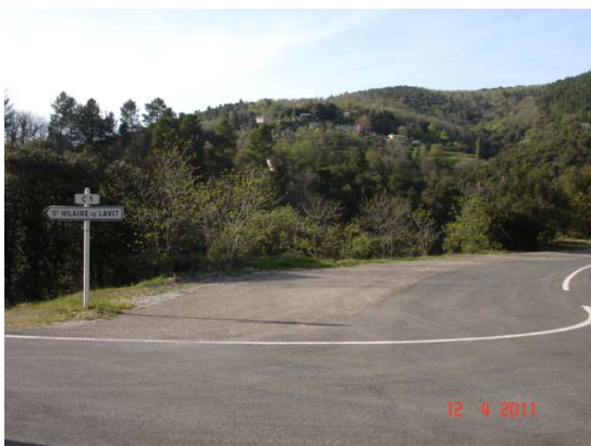
Site de stationnement amont sur la route nationale 106
