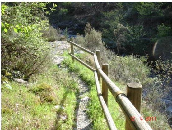
Barrière en bois vue depuis le haut
