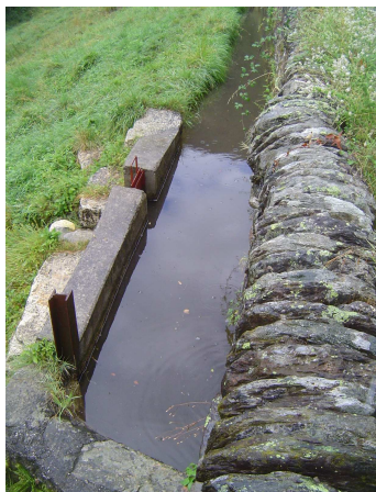
Photo 4 : point bas avec vanne de restitution
