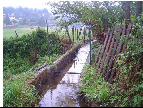
Photo 3 : Pont-canal traversant le ruisseau
