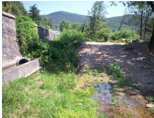
Photo 7 : Passage busé sous la route et pertes
