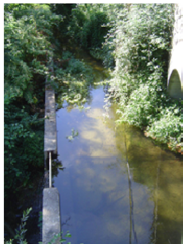
Photo 2 : Béal et vanne de restitution
