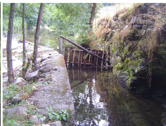
Photo 3 : Prise d'eau : palette de dégrillage
