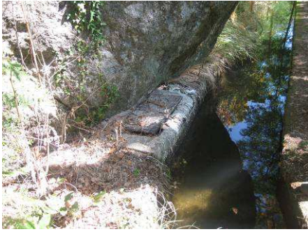
Photo 5 : Surverse du réseau d'eaux usées
