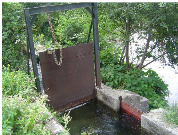
Photo 4 : 2°vanne de prise cadenassée et vanne de restitution
