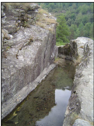
Photo 3 : Béal taillé dans la roche
