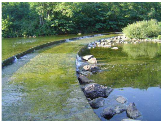
Photo 1 : Seuil de prélèvement Photo 2: passage busé
