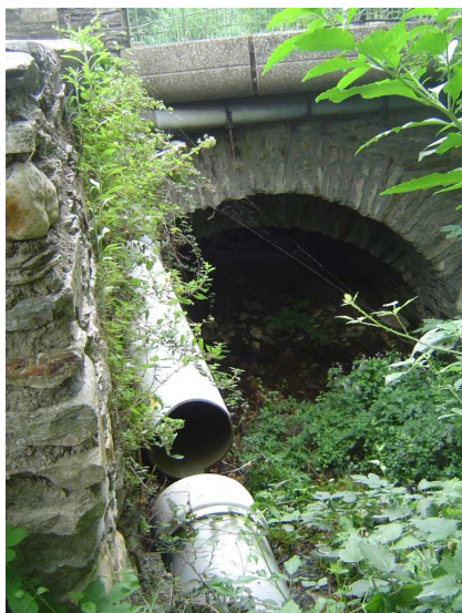
Photo 5 : buse coupée au niveau du pont
