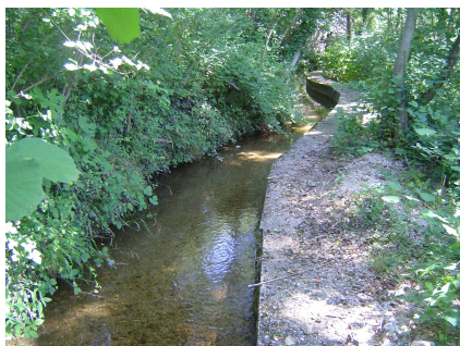
Photo 2: le béal au niveau de la prise : rive droite bétonnée et rive gauche creusée dans la terre.
