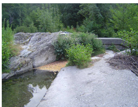
Photo 2 : Prise du béal, envahie par des flottants
