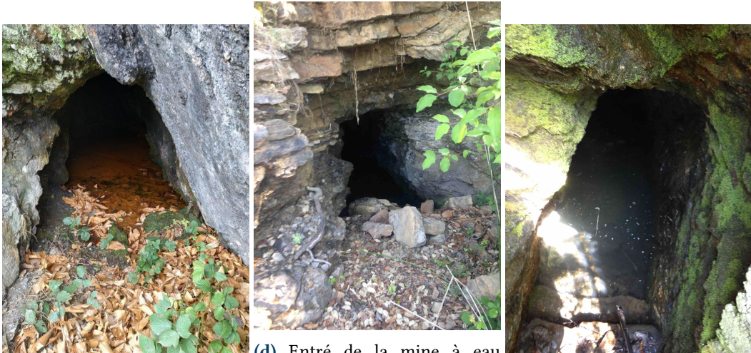
(c) Vue de la Galerie de la mine de Currières (commune de Thoiras). (d) Entré de la mine à eau du Col de l'homme mort. (e) Vue de la Galerie de la mine à eau du Col de l'Exil.
