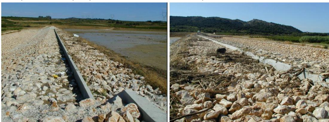
Figure 3-21 : Traces de surverse observées sur poutre du déversoir lors de la crue d'août 2004
