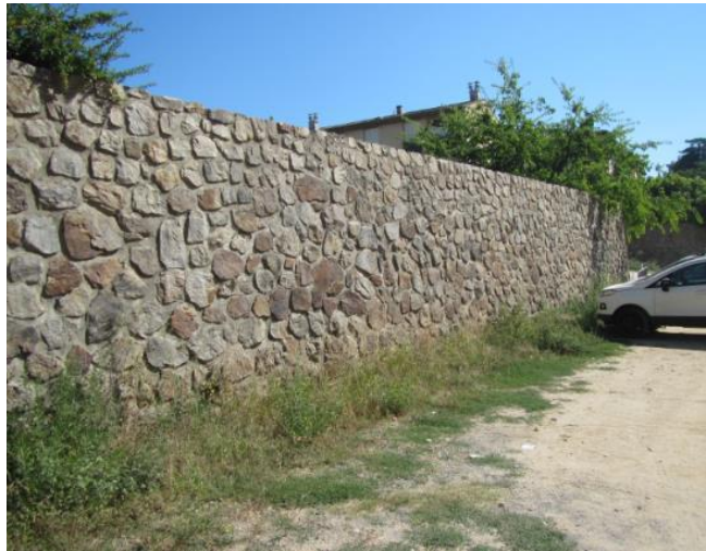
Figure 9 : Murs de protection au niveau du parking sur berges (côté Gardon)
