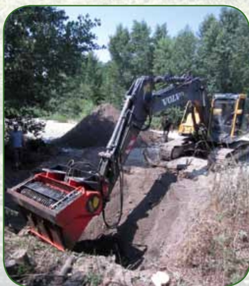
Arrachage mécanique des Renouées.
